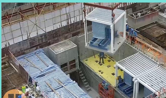
组装合成升降机机房
